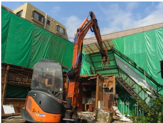
【写真 7】被害家屋の解体
